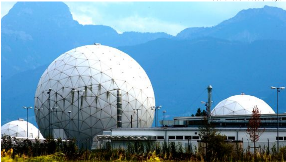
BND-Abhörstation bei Bad Aibling
